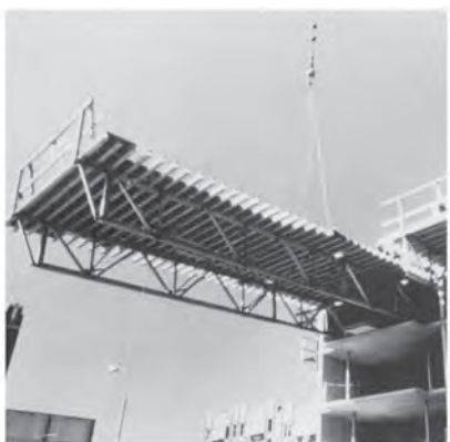
(d) Removing flying form table
