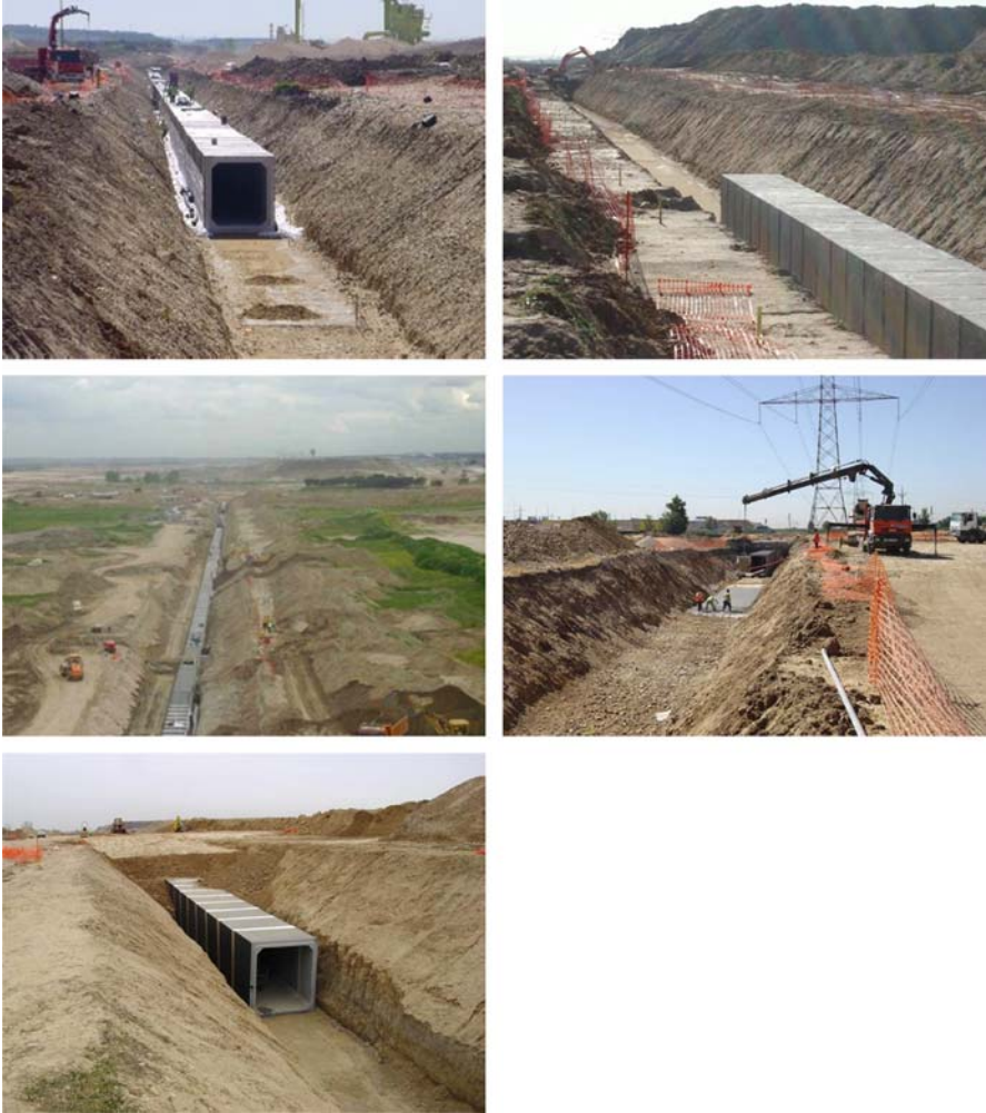
Figure 1.11 Tunnel under construction (Barajas) (Courtesy of RED Eléctrica de ESPAÑA)
