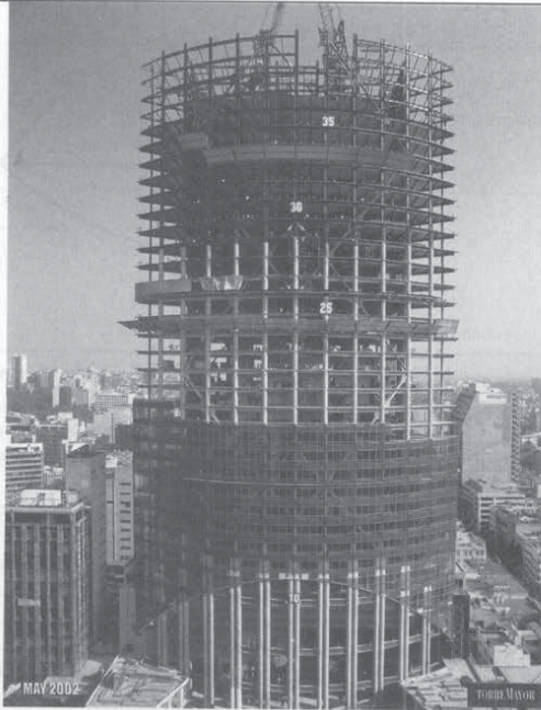
Torre Mayor, Mexico. Photo courtesy WSP Cantor Seinuk.
