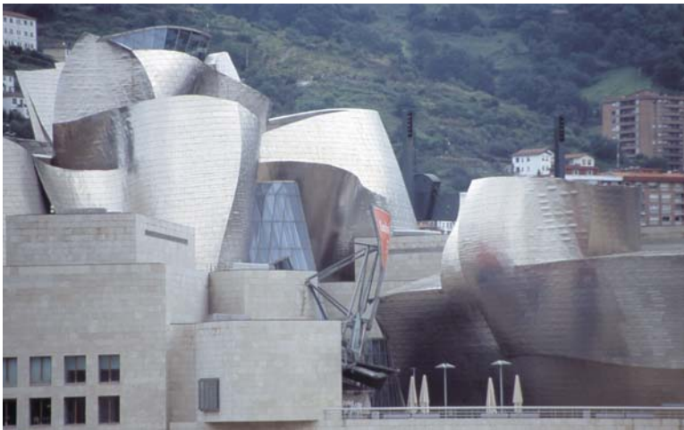
GUGGENHEIM MUSEUM BILBAO design: Frank O. Gehry (Photo: Bürdek archive)
