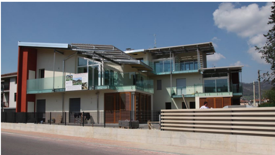
Figure 1 Residential complex ‘La Corte del Futuro’. © Atelier2 – Gallotti e Imperadori Associati.
