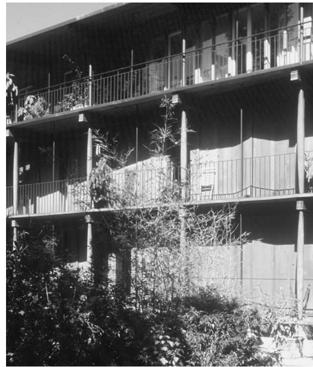
8.2 Wohnhaus im Hof, Basel (architect: Herzog & de Meuron)
