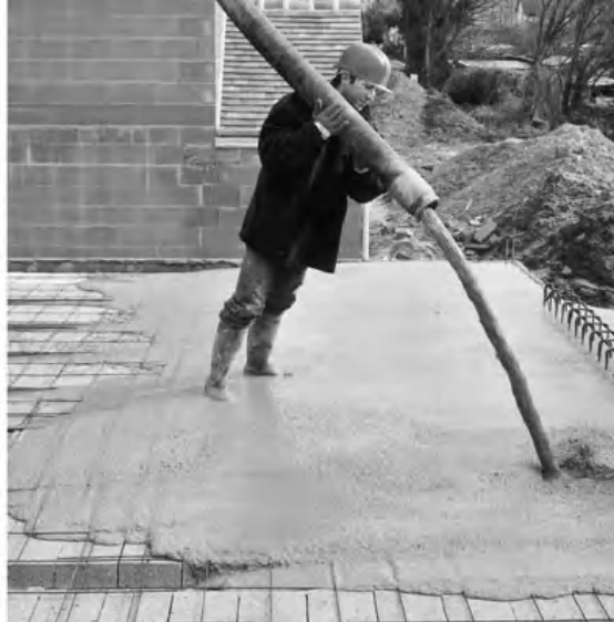
Figure 27.1. Casting self-compacting concrete (Photo: http://produits-btp.batiproduits.com )
