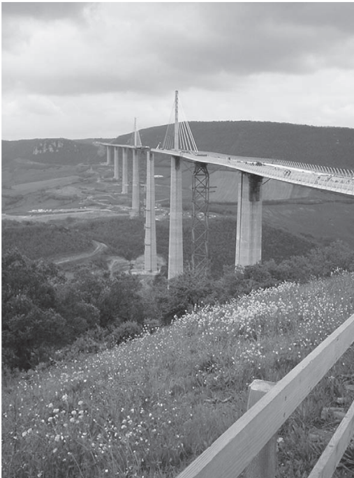
Figure 3.5 Viaduc de Millau.
