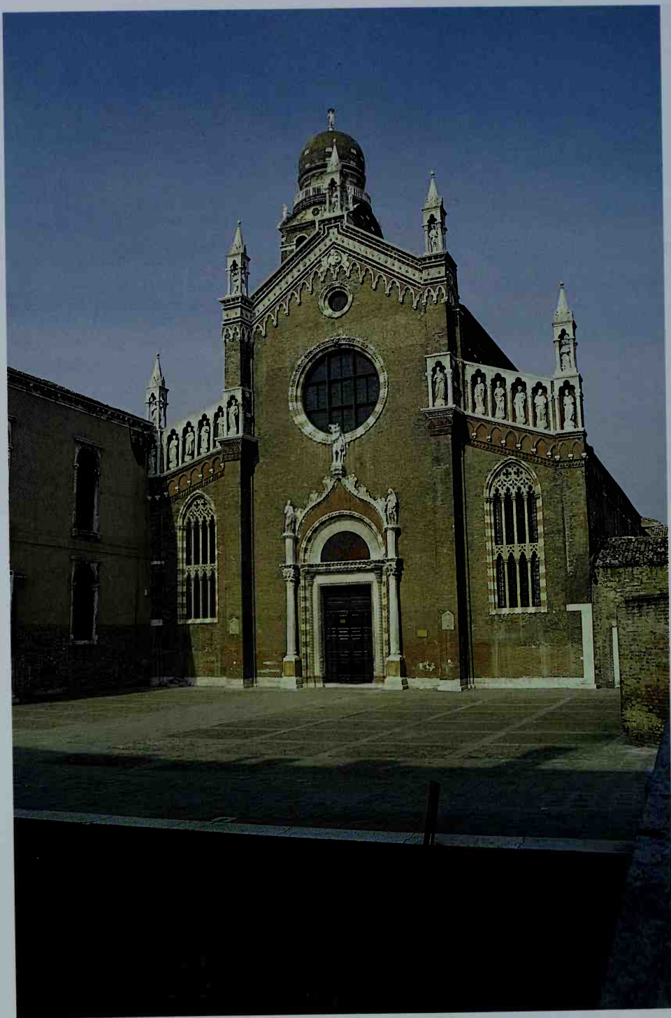
51 Madonna dell'Orto, begun c.1399; portal by Bartolomeo Bon begun 1460
