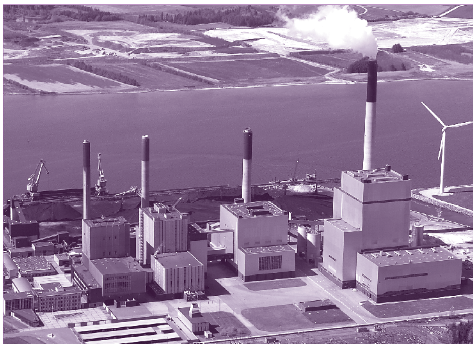
Figure 4 • Nordjyllandsværket general view
