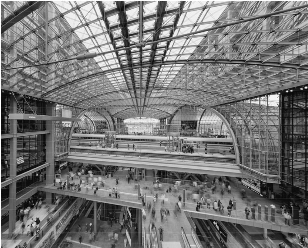
4.6 The interior of the Berlin Hauptbahnhof looking south. von Gerkan, Marg und Partner and Schlaich Bergemann und Partner, Berlin, Germany, 2006.
