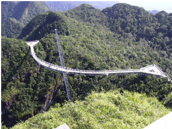
Fig. 1.10 Langkawi Sky Bridge.
